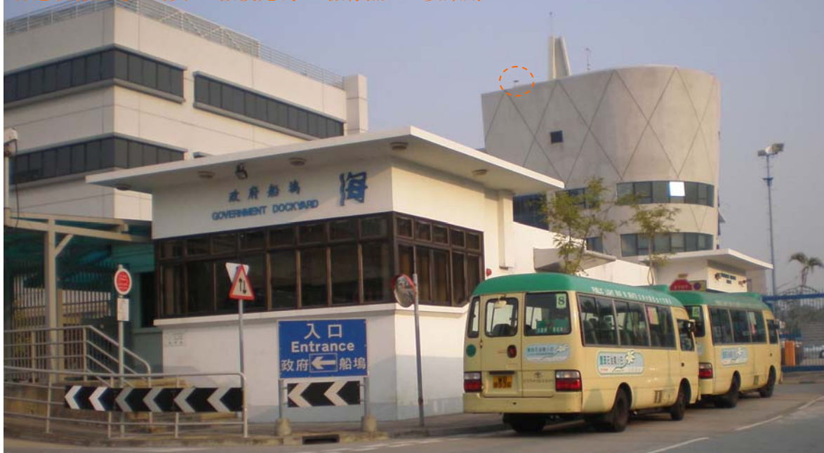
香港政府船坞 (码头), 微波无线 36 摄像点, 主要采用 TS16NW, TS806NW, TS802W
